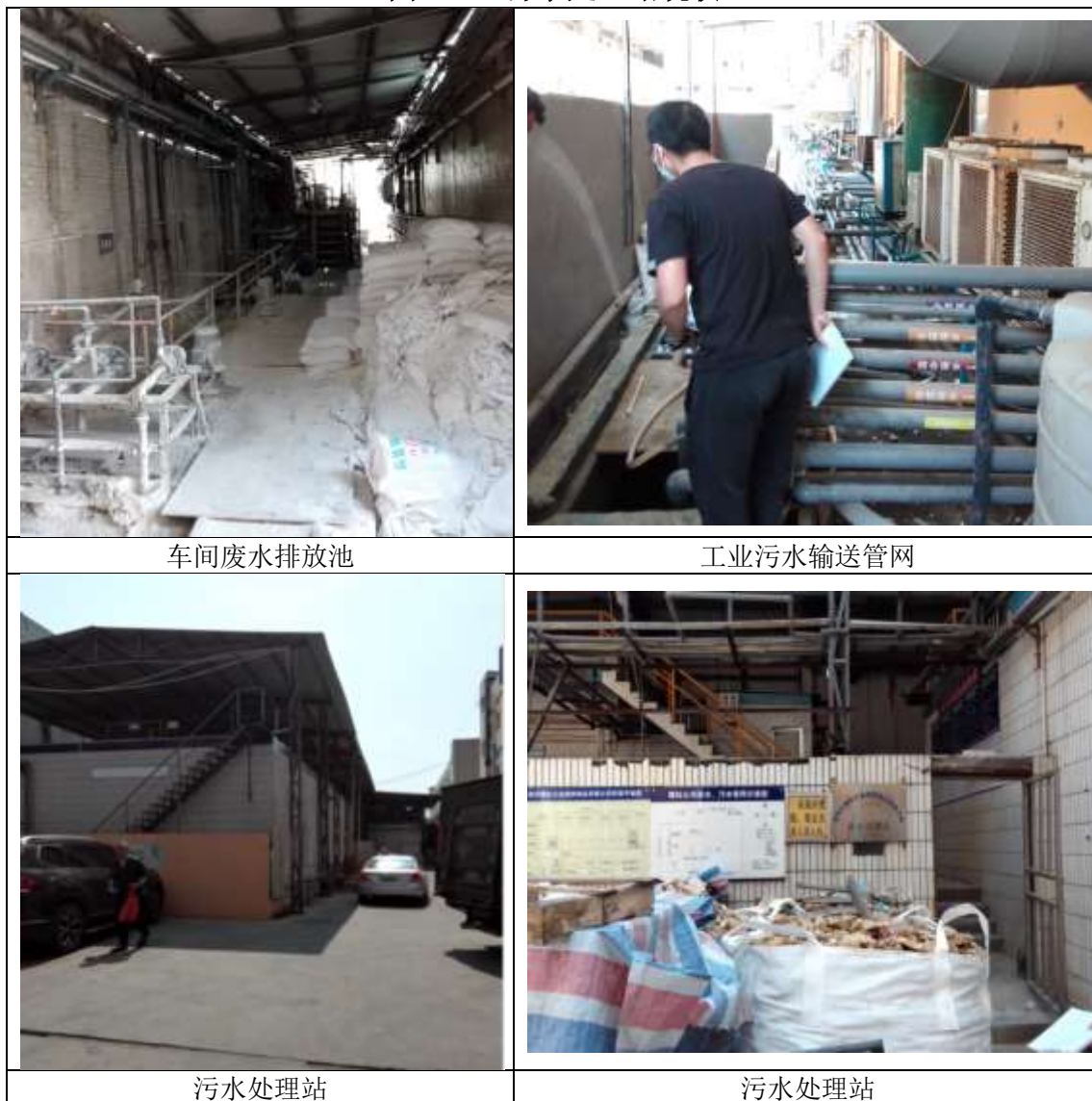
图 4.1-3 污水处理站现状
